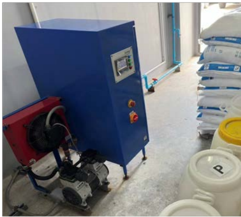
รูปที่ 2-24 เครื่องบำบัดอากาศ (Air Treatment Unit)
