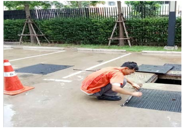
รูปที่ 2-27 การนำกรวยยางตั้งบริเวณฝาบ่อเมื่อมีการเข้า ดูแลและบำรุงรักษา
