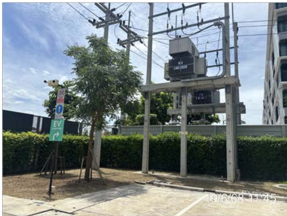
รูปที่ 2-42 หม้อแปลงไฟฟ้า
