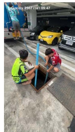
รูปที่ 2-23 สืบตะกอนและไขมัน
