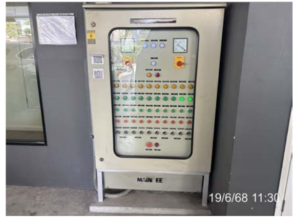
รูปที่ 2-58 ตู้ควบคุมระบบบำบัดน้ำเสีย
