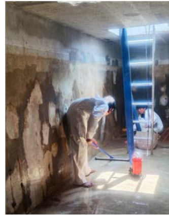
รูปที่ 2-31 การล้างถังเก็บสำรองน้ำ
